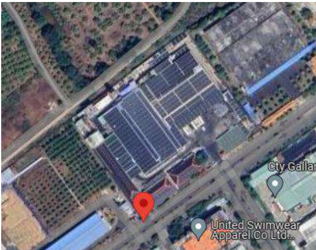
Hình ảnh vị trí hố ga đầu nối nước thải
